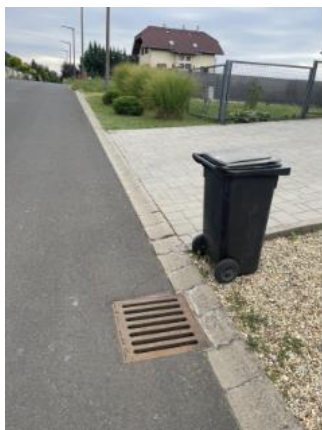
16. ábra: víznyelő rács a Napsugár utcában
