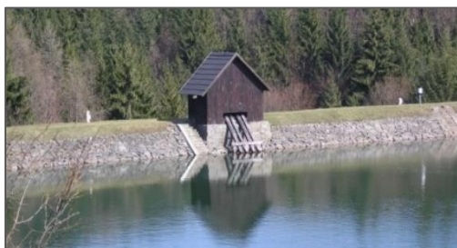
56. ábra – A rozgrundi-tó csapháza
